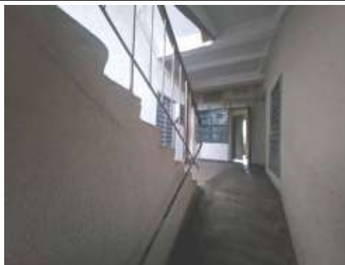
1.stāva kāpņu telpa
